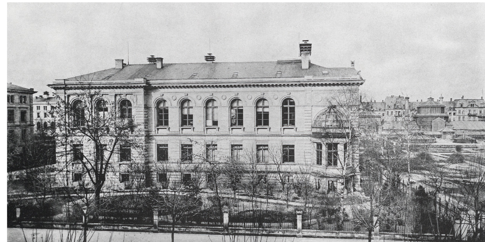
↑ L'Institut de botanique côté sud avec la petite serre expérimentale en forme de demi-hémisphère adossée au deuxième étage. À droite, en arrière-plan, on distingue les grandes serres qui seront détruites pour construire le nouvel Institut de botanique en 1964. Botanisches Institut mit den Gewächshäusern , S. Hausmann, 1897 © Coll. et fotogr. BNU de Strasbourg
